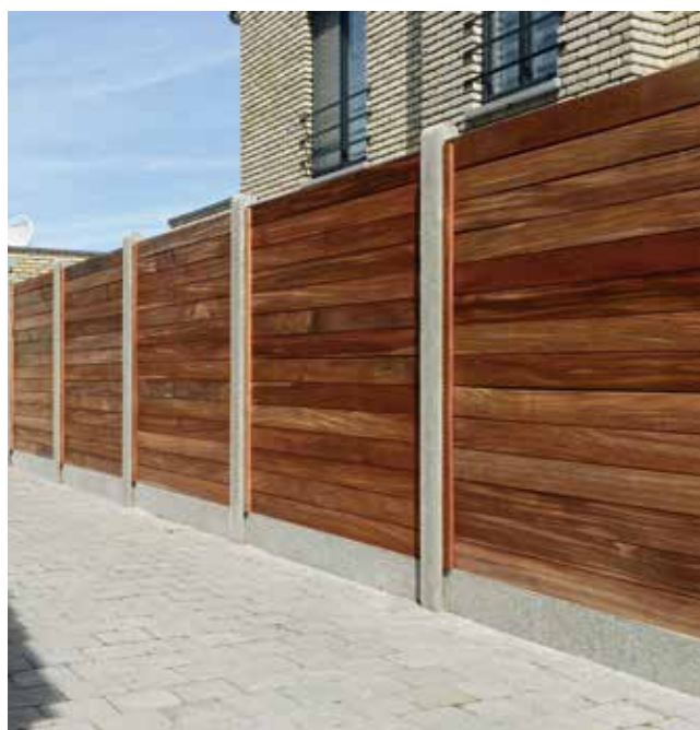
Omheining met massiefplanken okan in betonnen gleufpalen
