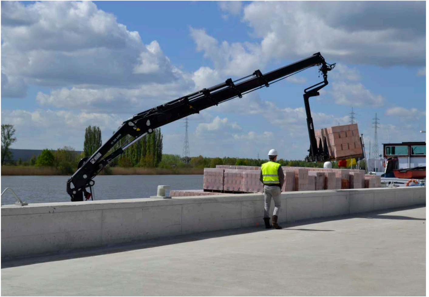
100 ste kaaimuur bij Coeck Beton te Niel.
