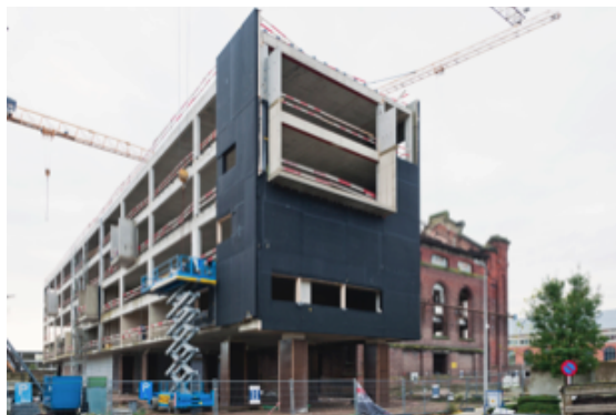
(FotoDeVerdieping2.jpg) (De houtstructuurwanden worden bevestigd aan de gebouwstructuur)
