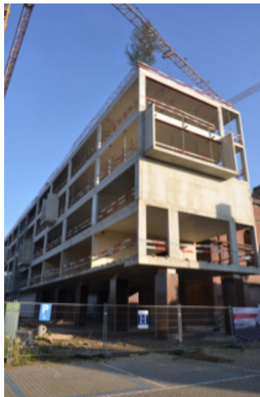
(FotoDeVerdieping1.jpg) (De betonnen gebouwstructuur van De Verdieping)
