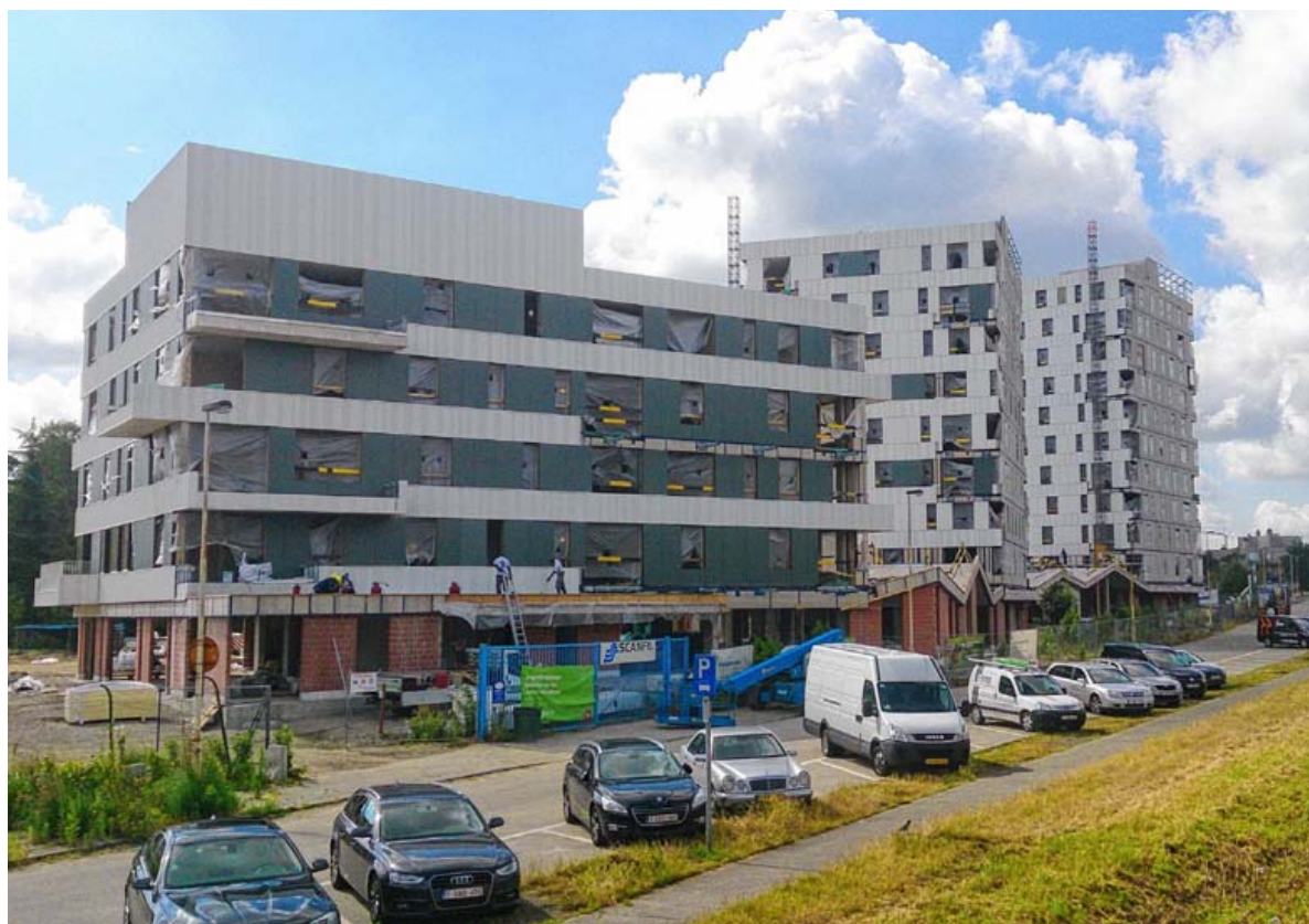
De gevelelementen van deze woningen op de Scanfil-site in Hoboken zijn van houtskelet gemaakt.
