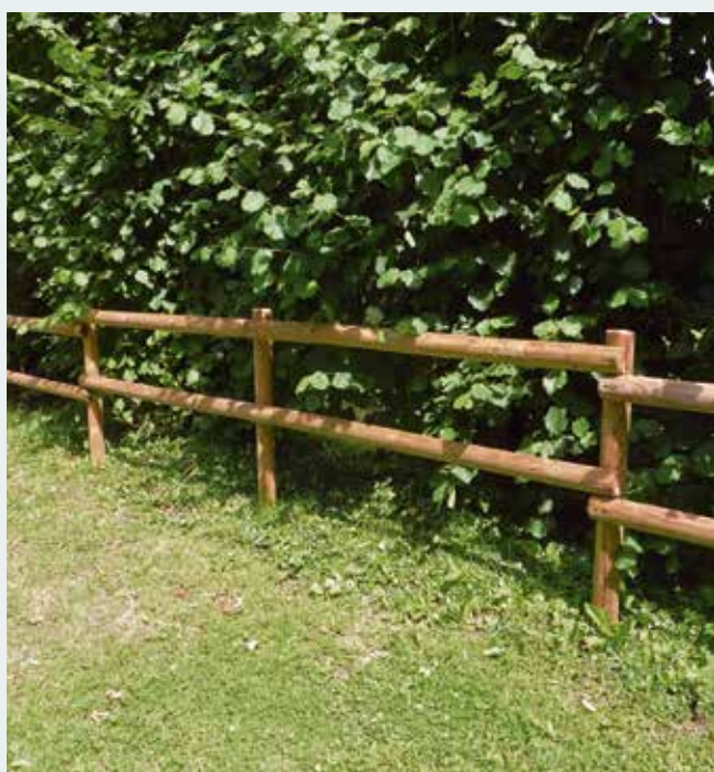
Een eenvoudige omheining in rondhouten palen en horizontale halfronde liggers, bevestigd met houtdraadschroeven.
