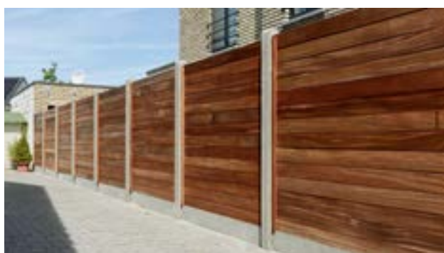
Massief scherm okan in betonnen gleufpalen met plaat onderaan
