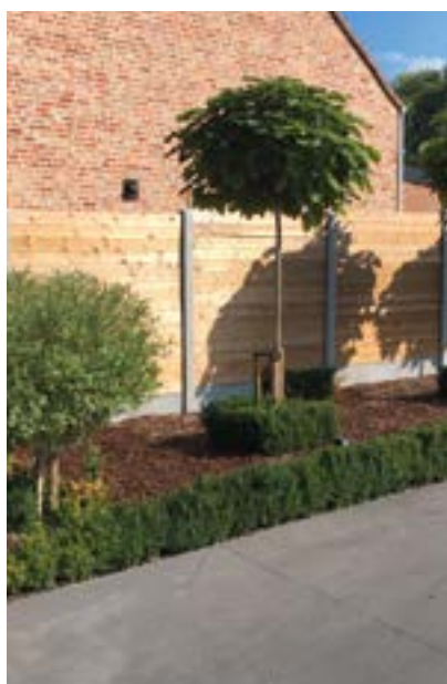
Massiefplanken in naaldhout in betonnen gleufpalen met plaat onderaan
