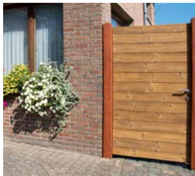
Geplaatst met poortpalen in padouk
