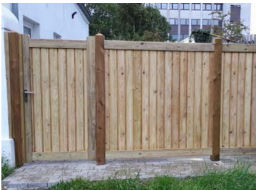
180 x 100 cm grenen met vaste panelen op maat gemaakt; hier met tand en groef planken
