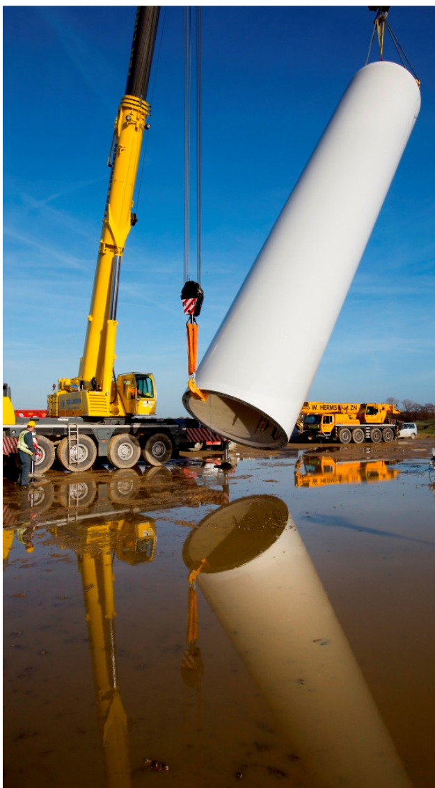
Opbouw van de windmolen in Tessenderlo, november 2013
