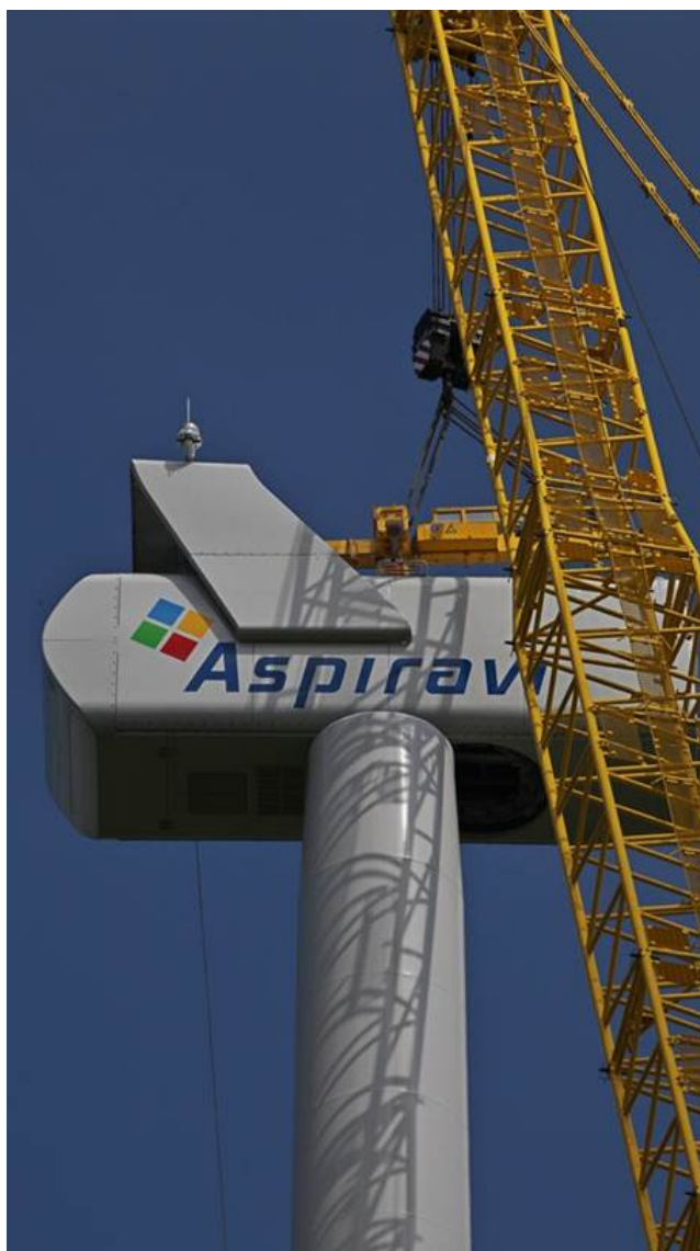
Opbouw windturbine Aspiravi
