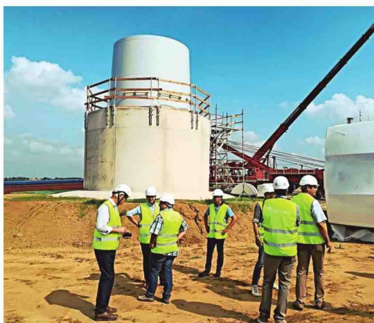
De funderingsblok waarop de mast van 114 meter komt.
