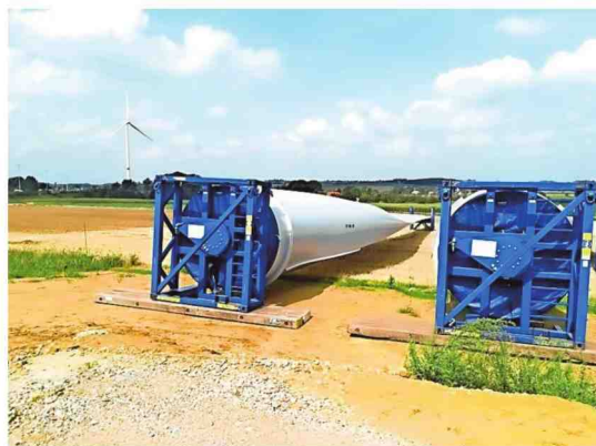
De drie wieken van 57 meter liggen klaar voor montage.
