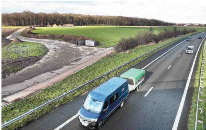
Links de aangelegde toegangsweg naar de werfzone voor het optrekken van de eerste van de twee windturbines van Aspiravi. De bouw van de tweede windmolen is ook gestart, vaag te zien rechtsboven op de foto helemaal in de verte. (foto JS)
