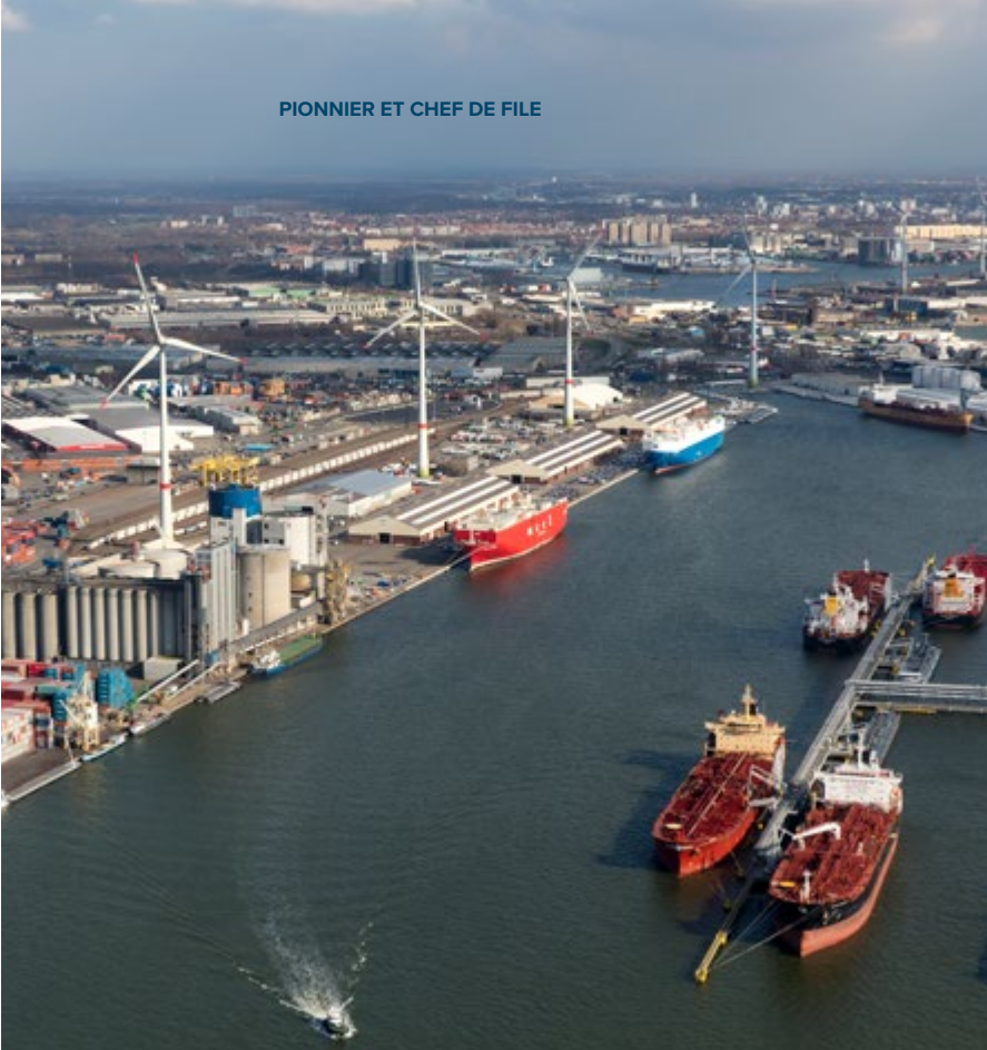
Parcs éoliens du port d'Anvers 34 éoliennes sur la rive droite et 21 sur la rive gauche
