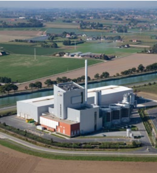
A&S Energie à Oostrozebeke Centrale à base des déchets de bois non recyclables
