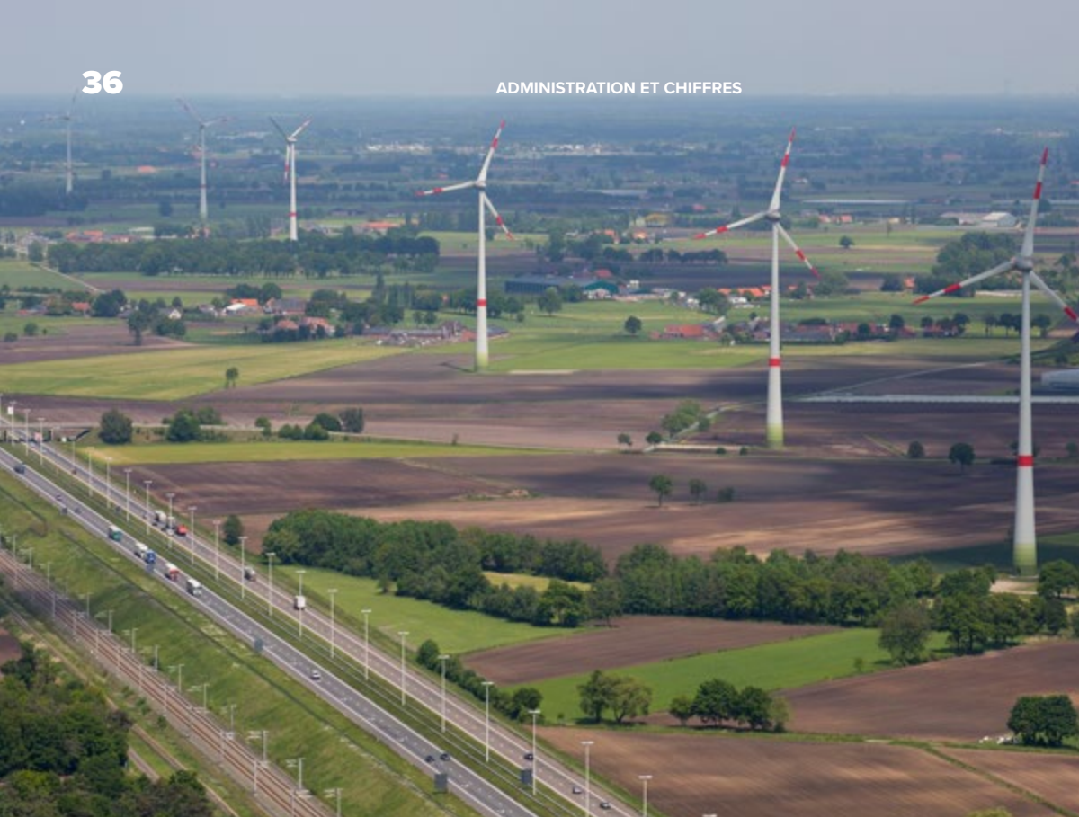
Parcs éoliens 'Noorderkempen' Brecht, Wuustwezel, Hoogstraten 12 éoliennes le long de l'autoroute E19 et de la ligne TGV
