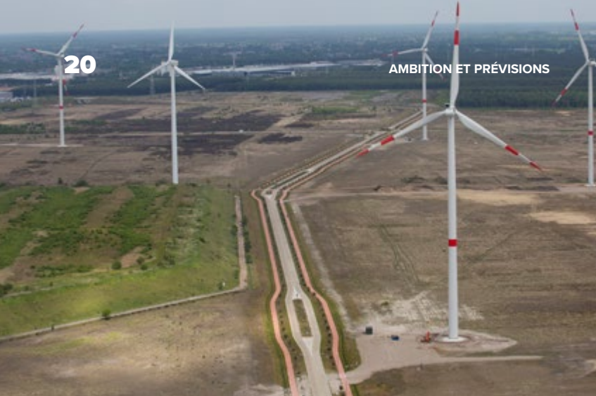
Parc éolien de Lommel 13 éoliennes sur le site industriel Kristalpark
