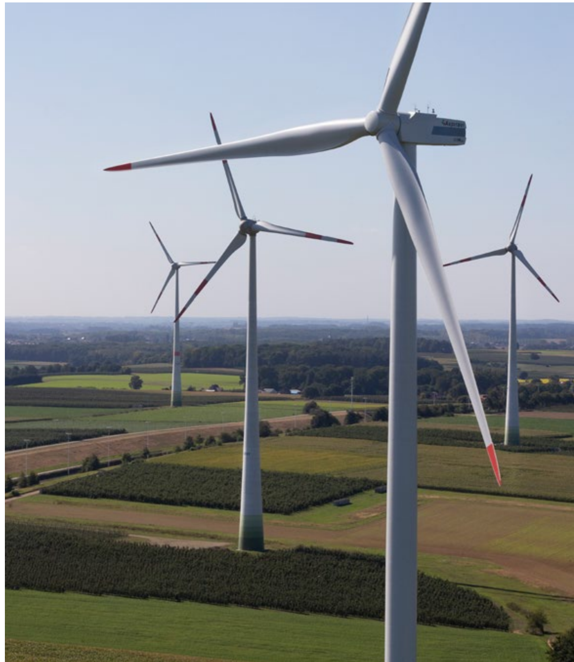
Parcs éoliens de Halen, Diest, Bekkevoort, Scherpenheuvel-Zichem 13 éoliennes le long de l'autoroute E314
